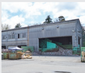
船橋リサイクルプラント
